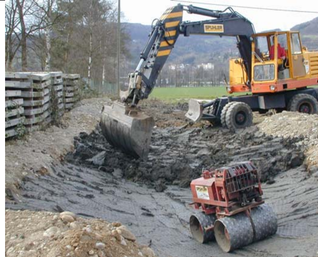
Weiher mit Lehmadichtung. Tiefe: Flachufer bis 1.8m / 50m 2
